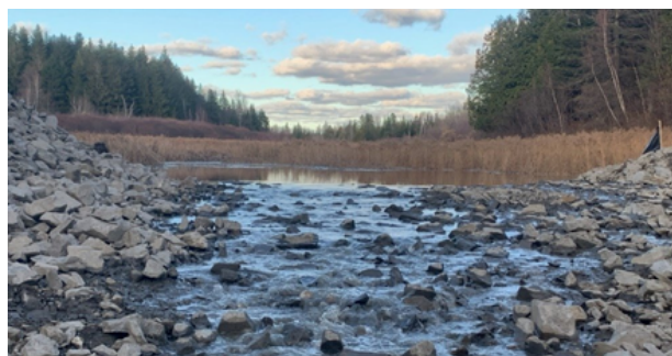
Photo: Déversoir aménagé du marais de la Meder
